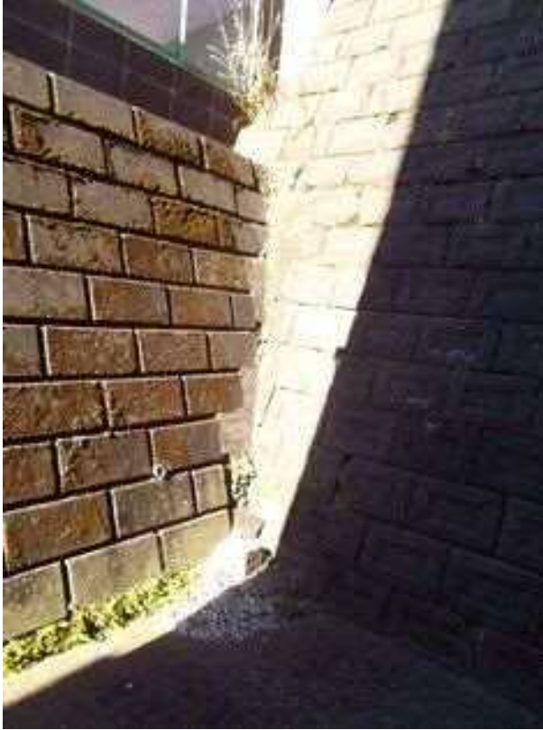
①南西側：共用よう壁の状況
