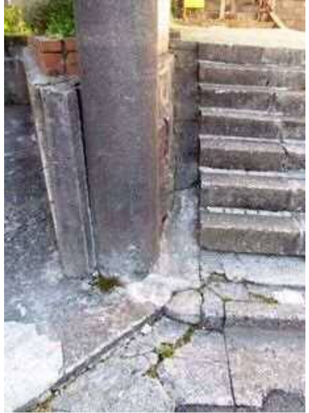
②北東側：接道境界部の電柱設置状況
