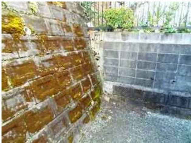
③北側：隣接宅の追加造成状況
